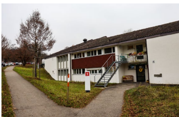
Bildlegende: Zu ersetzende Gebäude in Zetzwil
